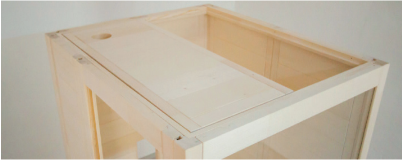
Afb. 14: Plaatsen van dakelementen voorzijde
