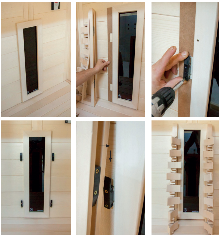
Fig. 29: Montagem dos encostos
