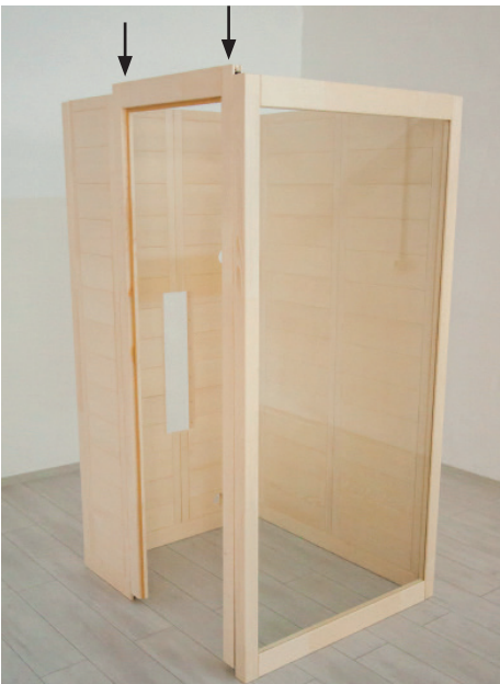
Fig. 10: Installing the door frame
