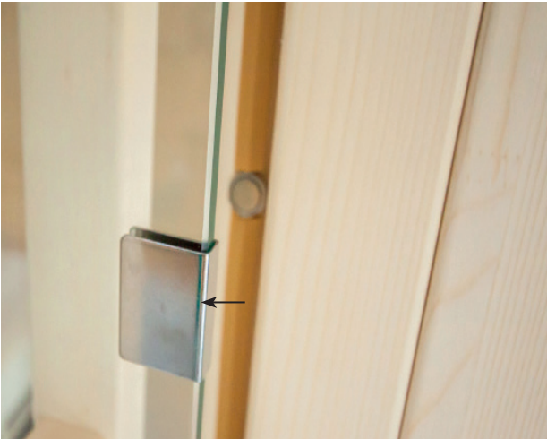
Fig. 35 : Montage de la tôle extérieure
