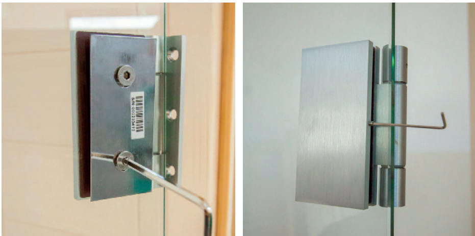
Fig. 32 : Montage des ferrures de portes 2
