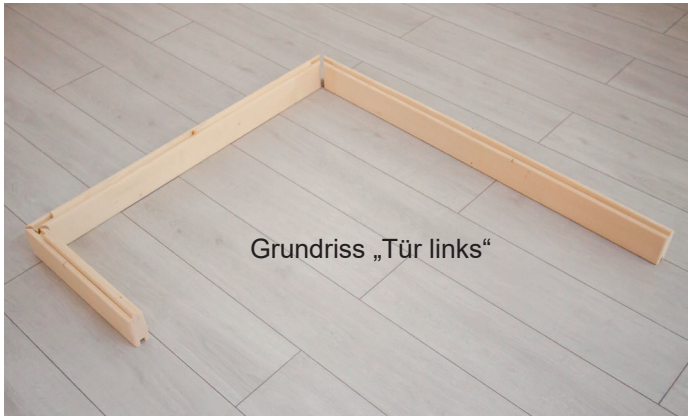
Abb. 1: Auflegen der drei Bodenrahmen-Elemente
