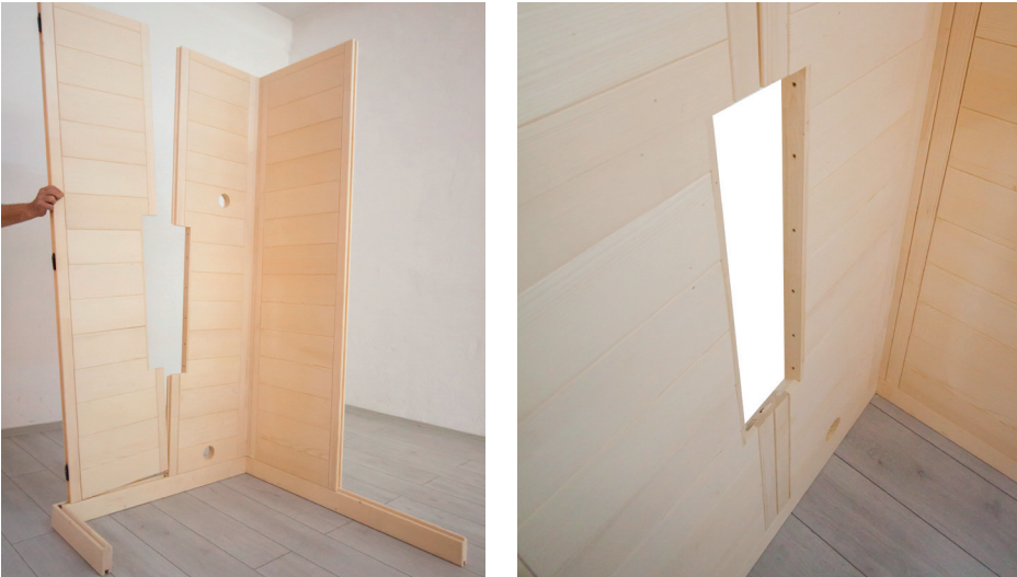
Abb. 6: Wandelement mit Ausschnitt einsetzen
