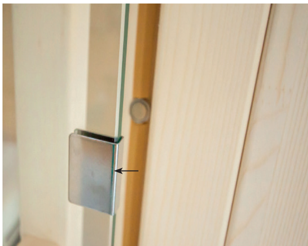
Fig. 35: Montagem da chapa de transferência
