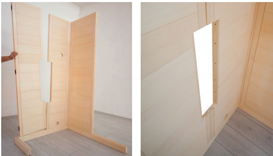
Fig. 6: Instalar o elemento de parede com abertura
