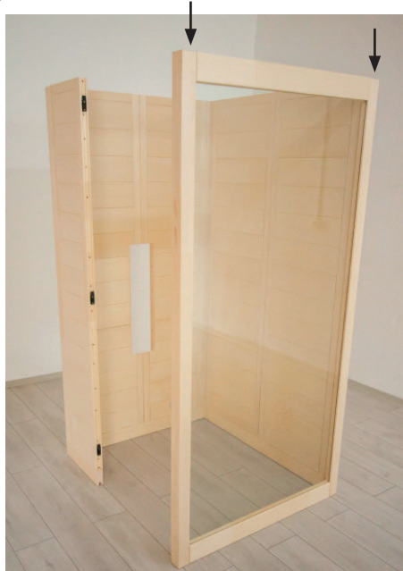
Fig. 10: Installing the door frame
