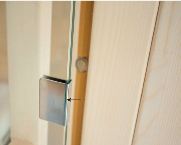
Abb. 35: Montage Überschub-Blech
