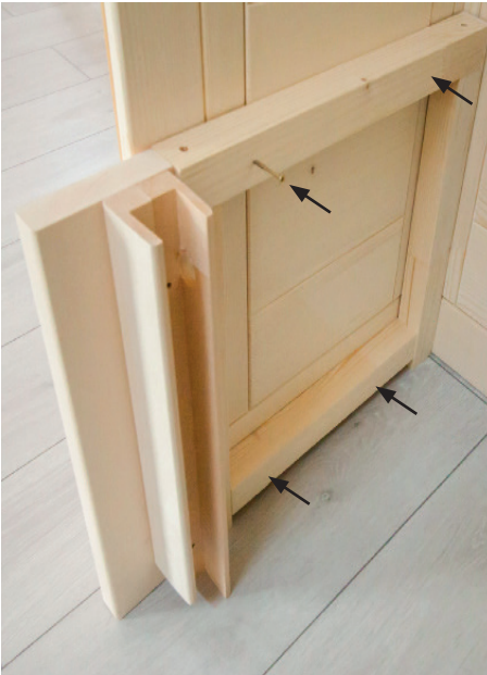
Fig. 18 : Monter les supports du banc
