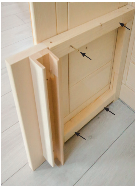
Fig. 18: Montar os apoios do banco
